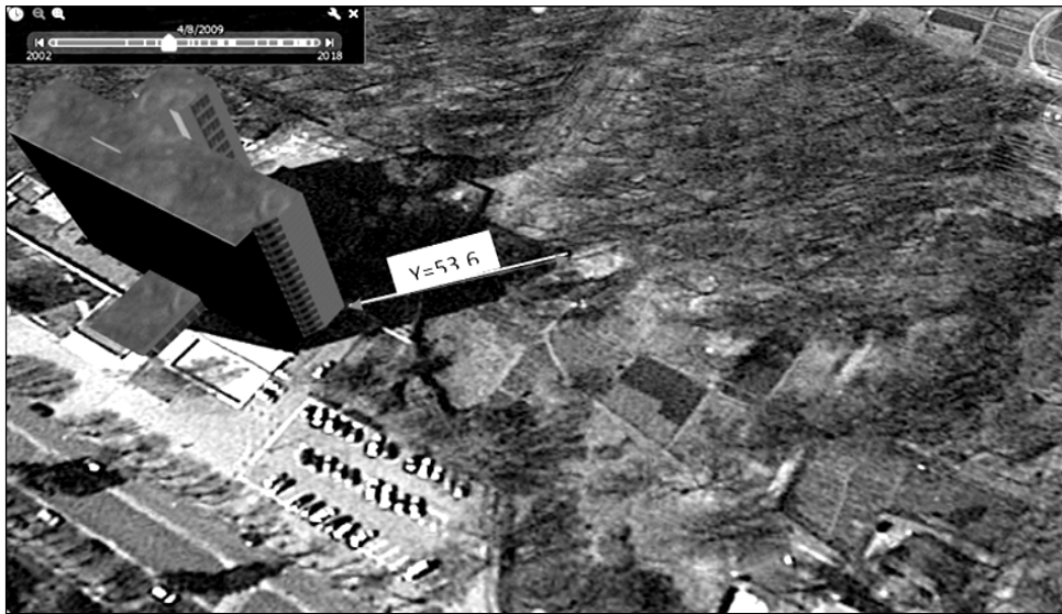
Рис. 2. Измерение длины тени главного корпуса ДНУ на снимке из Google Earth
